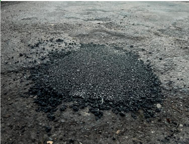
Das Produkt ist mindestens 24 Monate lagerfähig, angebrochenes Material kann ohne Qualitätsverlust wiederverwendet werden. Optisch und technisch entspricht **eka® Recyphalt®** einem klassischen Heißasphalt und kann jederzeit mit Heißasphalt überbaut werden.
